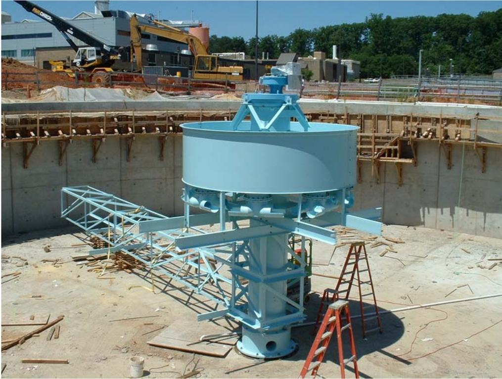
Figure 1: Energy Dissipating Inlet (LA-EDI)
